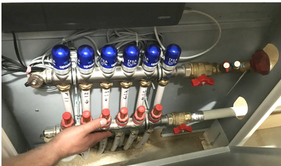
2.9. att. Uponor C-56 (augšpusē) ar izpildmehānismiem (zilā krāsā).
